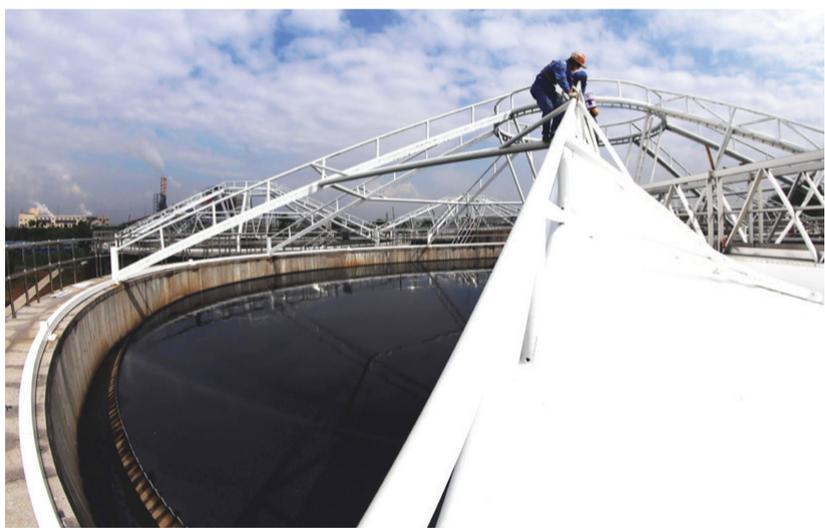
日前，江滨水处理公司泥处理除臭系统的8个污泥浓缩池全部完成钢结构膜安装工程。该除臭系统由8个钢结构反吊膜装置及2套生物除臭装置组成，总投资480万元。除浓缩池外，此前已对稳流池进行了除臭改造，今年还将对脱水车间、污泥均质池、储泥池、上清液回流泵房等进行臭气收集处理，预计至10月底可完成全套臭气处理装置安装调试并投运。届时，江滨水处理公司厂区内将实现重点区域高浓度臭气全收集、全处理，处理后排放的废气可达到国家排放标准。（江滨水处理公司 樊兆勇 文 罗超 摄）
